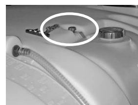
Tirador del desagüe sobre la parte superior de la cisterna.
